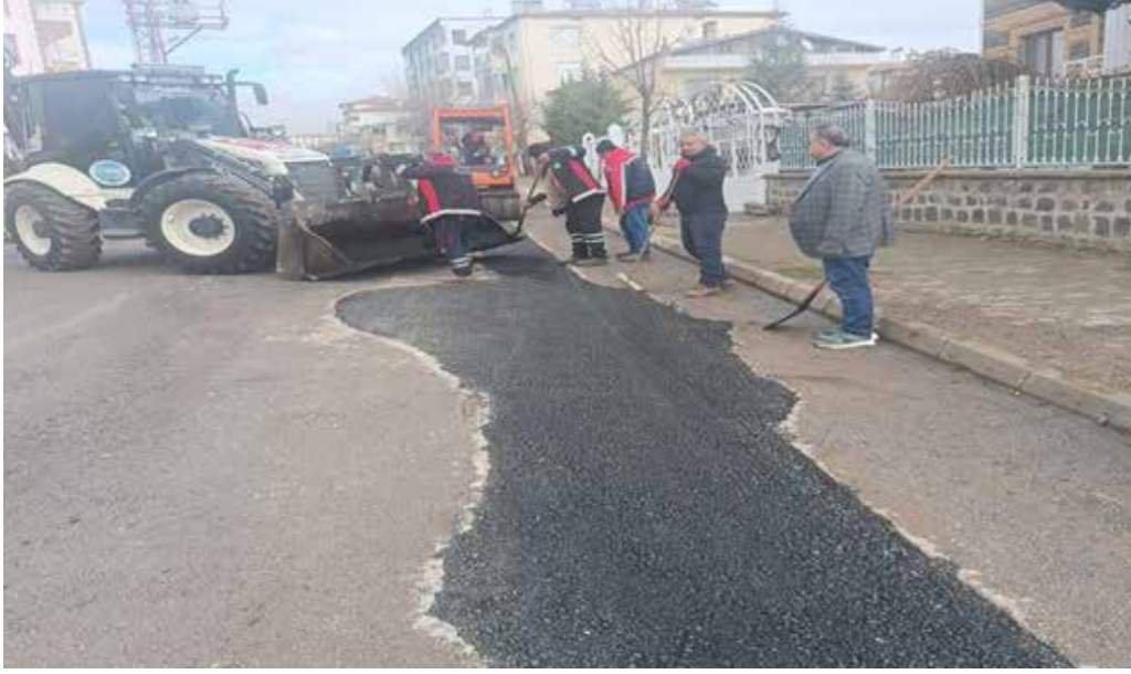
Sıcak Asfalt Yol Kaplaması
